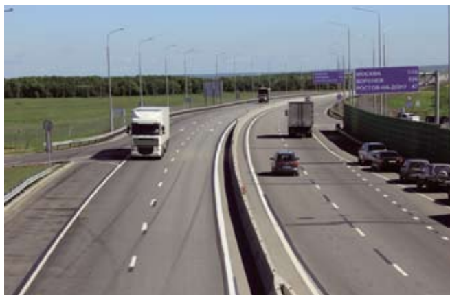
Автомобильная дорога М4 «Дон»
