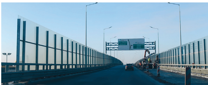
Двухъярусный путепровод через Московский проспект, шумозащитные конструкции
