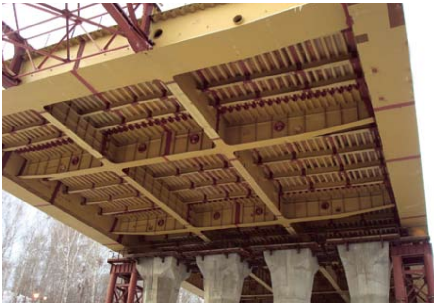
Рис. 6. Продольная надвигка пролетных строений 1-5, 5-6
