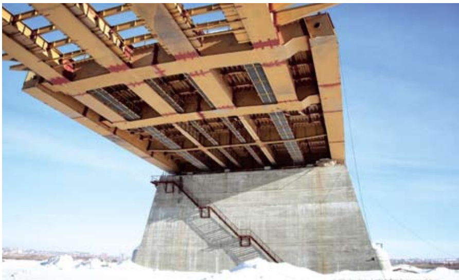
Рис. 7. Последовательная сборка и надвигка пролетных строений 1-5, 5-6
